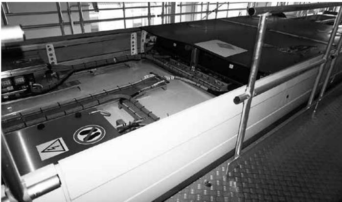
In der neuen Werkstatt erreicht man die Batterien auf dem Dach der E-Busse über eine sicherere Bühne.
