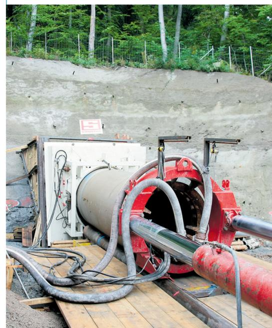
Die Ableitung von Abwasser aus dem Stadtteil Hermann-Röchling-Höhe sollen riesige Betonrohre sicherstellen, die derzeit im Waldgebiet weit unterhalb der Bebauung auf der Höhe mit großem technischen Aufwand in den Berg gepresst werden. Bisher wurden die bei starken Regenfällen anfallenden Wassermengen über einen einhundertfüßigen Meter langen offenen Graben in ein Regenrückhaltebecken über der Bundesstraße 51 zwischen Völklingen und Bous abgeleitet und gesammelt. Da der offene Graben in einem be-
