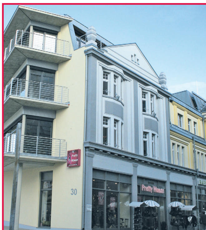
Jugendstil-Häuser: Mitte September waren endlich mit dem letzten Eckhaus alle vier sogenannten Jugendstilhäuser in der Völklinger Innenstadt saniert. Der Innenstadt ist so ein repräsentativer Teil ihres historischen Gesichts erhalten geblieben.
