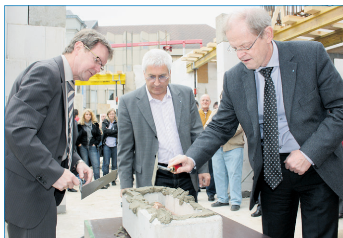
Geschäftsführer der GSW Dieter Fücksle (links), Oberbürgermeister Klaus Lorig (Mitte) und Bürgermeister Wolfgang Bintz bei der Grundsteinlegung Foto: jm
